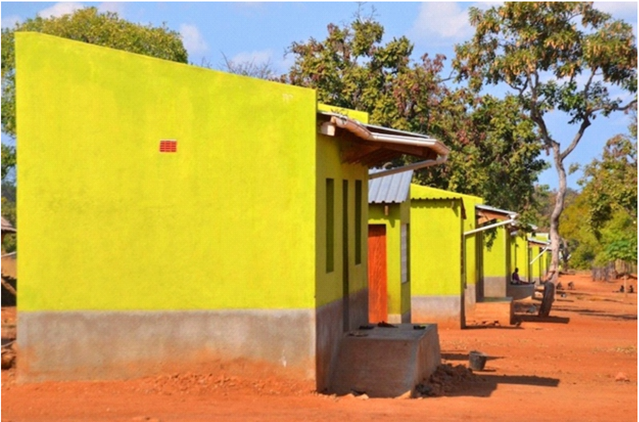
Vista parcial da Aldeia de Reassentamento de Mwaladzi
