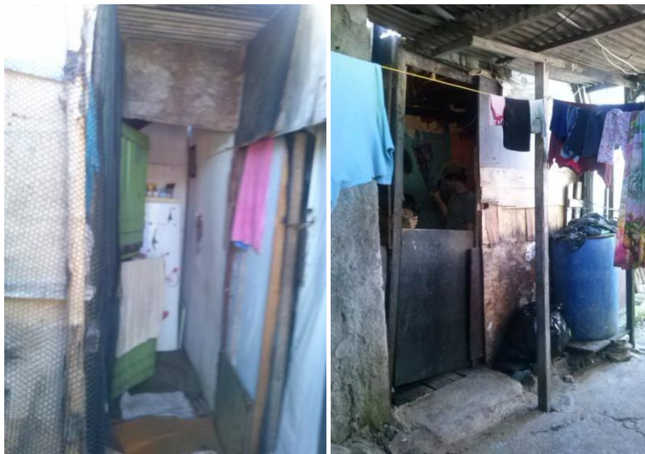
Figura 61 e 62: Moradias nas palafitas onde foram realizadas as medições. Fotografia: autora.
