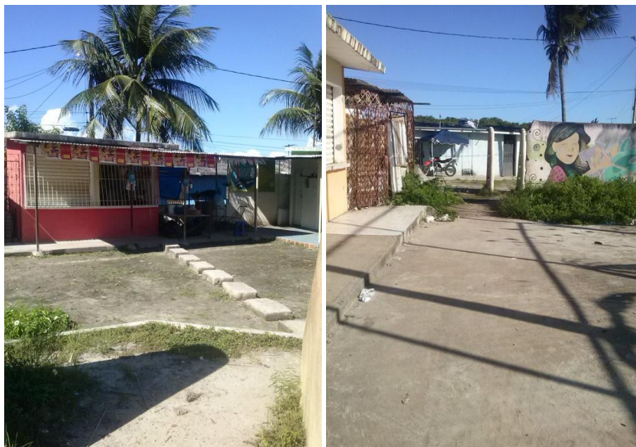
Figura 39 e 40: Quiosque e Muro quebrado para acesso à rua que margeia o mangue. Fotografia: Autora.
