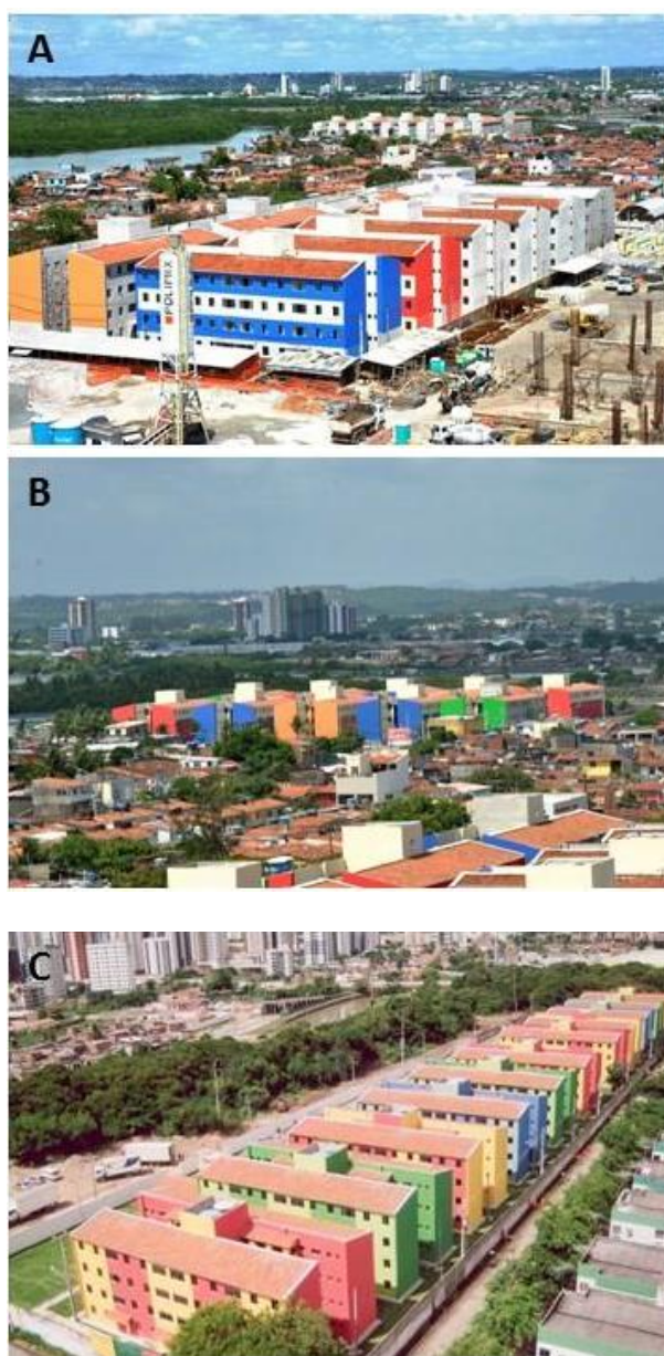
Figura 28: Imagens dos conjuntos habitacionais Via Mangue I, II e III: A imagem ‘A’ corresponde ao conjunto Via Mangue I, em fase de construção; Na imagem ‘B’ apresenta o conjunto Via Mangue II; E a imagem ‘C’, o conjunto Via Mangue III; Fonte: Portal Copa Transparente; Disponível em: www.copatransparente.gov.br/acoes/via-mangue-desapropriacoes ; Acesso em: 24 de março de 2015.
