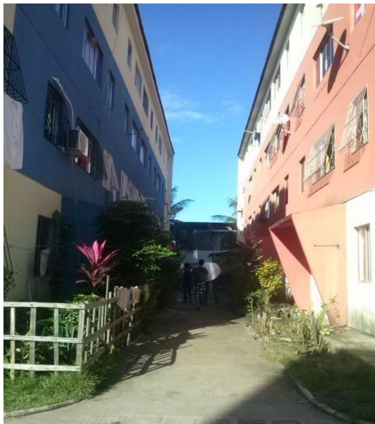
Figura 58: Ponto de medição no entre os edifícios do conjunto habitacional Via Mangue II. Fotografia: autora.
