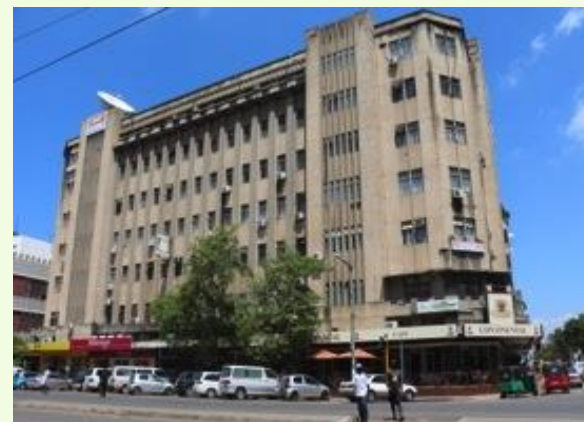
Inspecção-Geral Av. 25 de Setembro 1509
