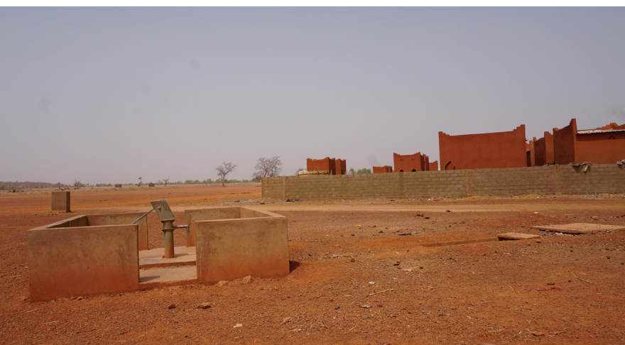
Puit hors-service dans le nouveau village de Bouly (Photo: Merle Groneweg, 2017)
